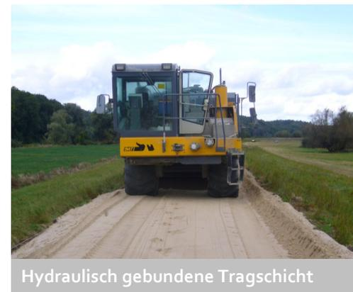
Hydraulisch gebundene Tragschicht
