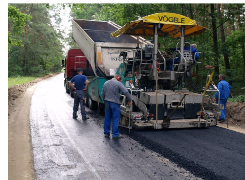
Einbau der Tragschicht
