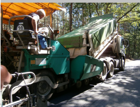
Einbau der Deckschicht
