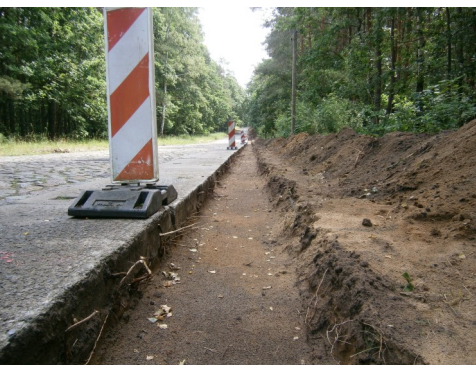
Aushub der Verbreiterungsbereiche
