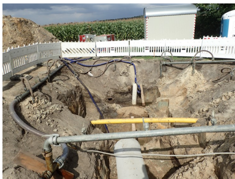
Verlegung von Leitungen und Medien
