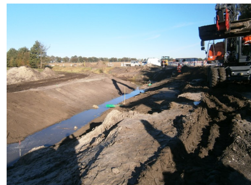
Verlegung des Fließgrabens
