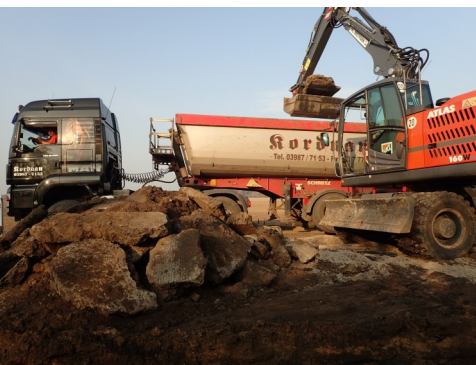
Abbruch der vorhandenen Fahrbahn
