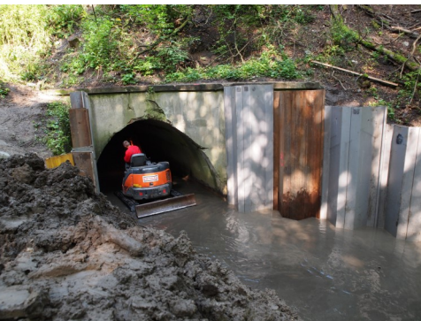
Reinigen der Bauwerkssohle
