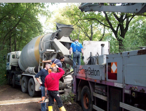
Verfüllen des Ringraums
