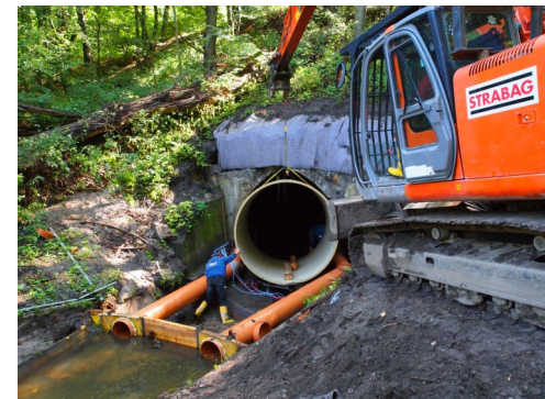
Einschieben der Inliner
