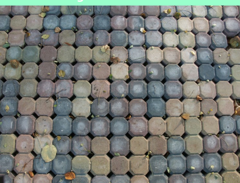
Bemusterung des Pflasters
