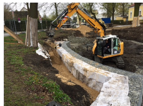
Einbau von Gabionen
