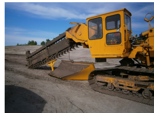
Einfräsen von Entwässerungssträngen
