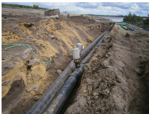
Verlegung von Hebern
