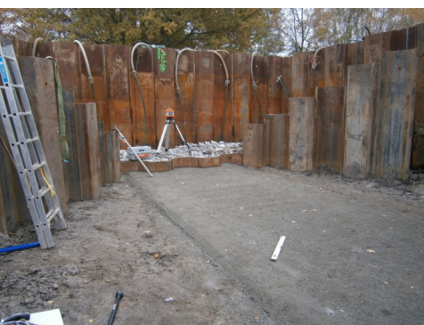
Baugrube und Gründung
