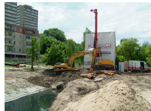
Abfangung umliegender Gebäude
