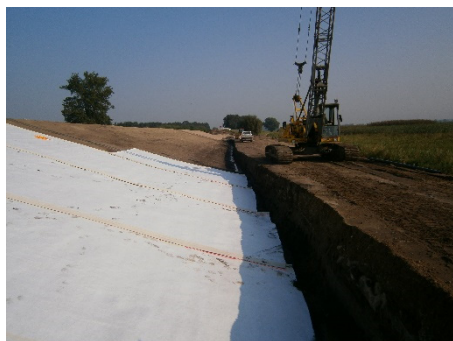
Verlegung von geotextilen Dichtungsbahnen
