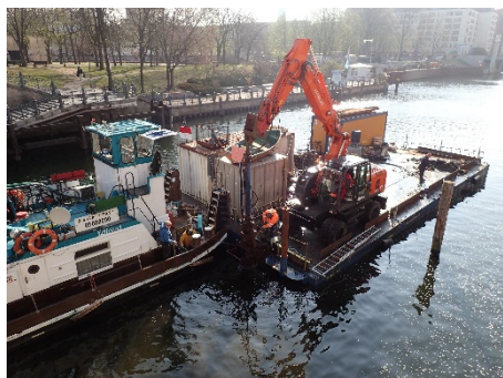
Räumarbeiten an der Liebknechtbrücke
